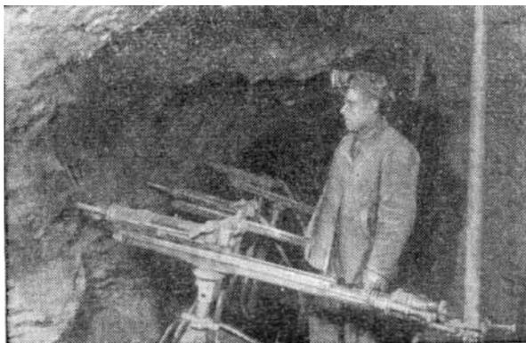
*Бригадир бурильщиков шахты имени Ворошилова треста «Дзержинскруд» А. А. Осмак успешно применил бурение горизонтальных и наклонных скважин одновременно несколькими колонковыми молотками «КЦМ-4».*
