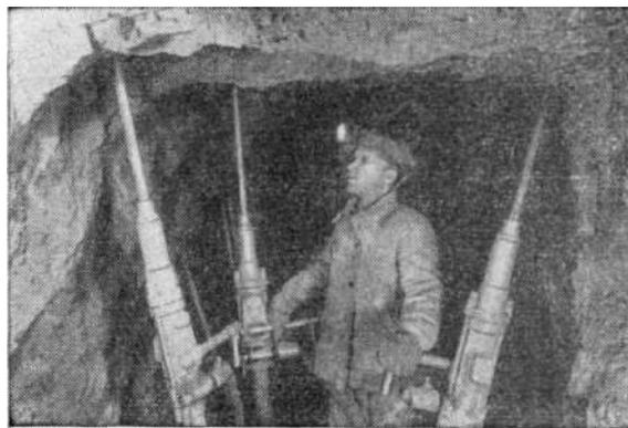
*Бурильщик А. К. Фролов (шахта имени Ворошилова, Дзержинского рудоуправления) за работой в забое. При бурении вертикальных скважин тремя тяжелыми молотками «ТП-45» он выполняет за смену по две нормы.*
